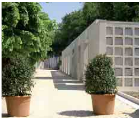
L'ampliamento del cimitero di Salò.
